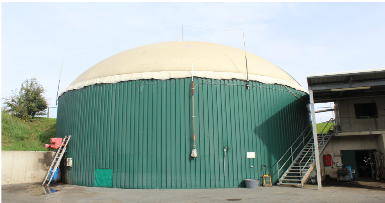
Снимки 10. БЛИЗЪК ПЛАН НА БАЛОНА ЗА ГАЗ НА ИНСТАЛАЦИЯ В СТРЕМ - ГЮСИНГ
