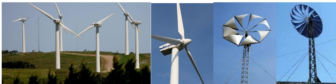
Фиг. 3.19. Видове вятърни генератори: а - с две; б - с три; в - с много лопатки
